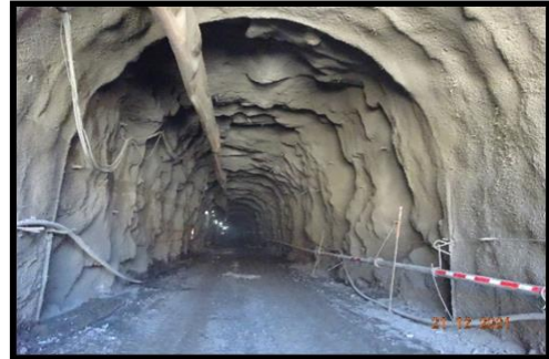
Vista General Túnel de Desvío – Portal Entrada
