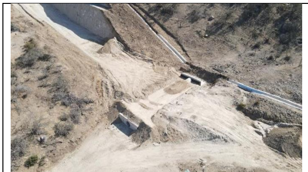
Fotografía N°1, Vista OA N°15. Variante Ruta E-315
