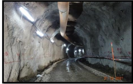
Vista General Túnel de Desvío - Portal Salida
