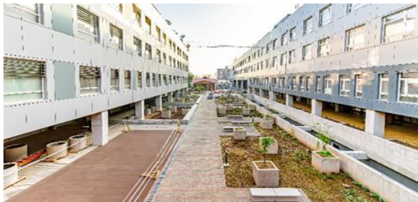
Fachadas ING y HDS
