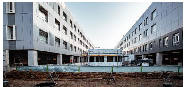
Central de gases
