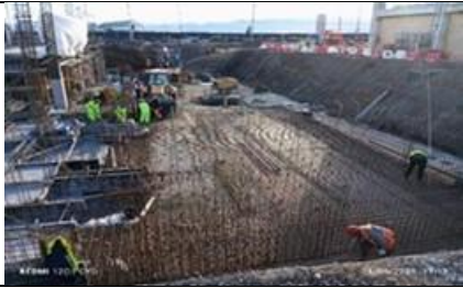
Edificio Estacionamiento Cubierto
