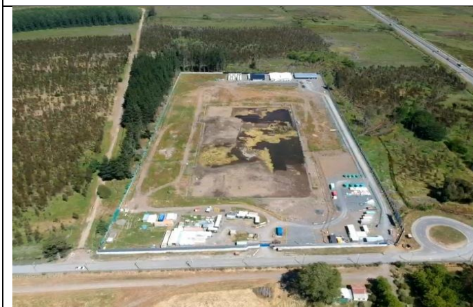
Vista aérea Hospital de Coronel
