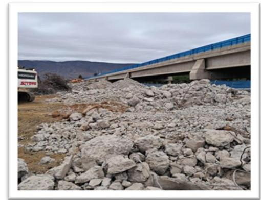
Foto 3: Ruta 5, Detalle de escombros generados por demolición de losas y cepas.
