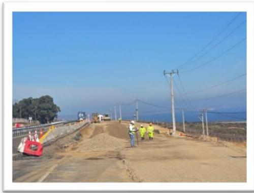
Foto 5: Ruta 5, Km 247, Terraplén en Calzada Izquierda. Este se encuentra en ejecución para ensanche de plataforma.
