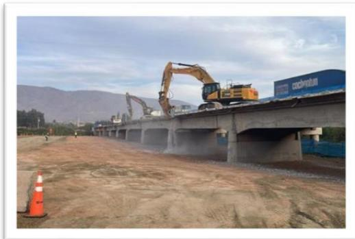
Foto 1: Ruta 5, Inicio de trabajos de Demolición Puente Huentelauquen.
