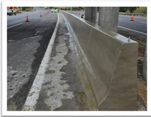
Foto 6: Ruta 5, Enlace Quebrada Seca, Barreras de Protección en pilares.
