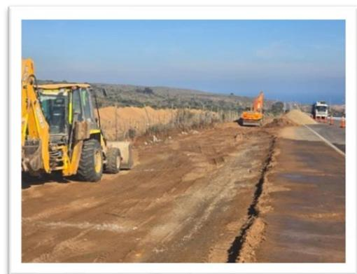
Foto 4: Ruta 5, Km 235, ensanche de plataforma para desvíos por construcción de atravesio Playa Ñague.
