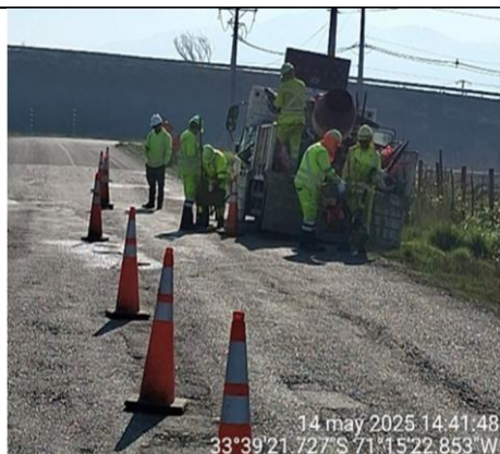
Mantenimiento de Calle de Servicio Derecha km. 71+900-
