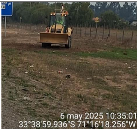
Mantenión Obra de Arte km. 73+600 ascendente
