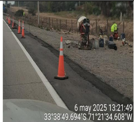
Mantenión de Bermas 76+200- descendente
