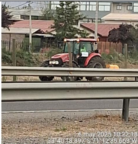
Roca mecanizado km. 69+900- ascendente
