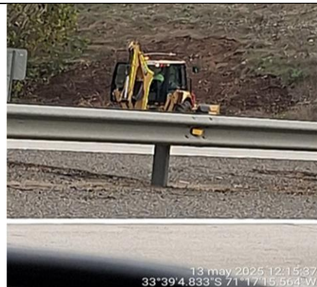
Retiro de escombros CSD km. 75+000
