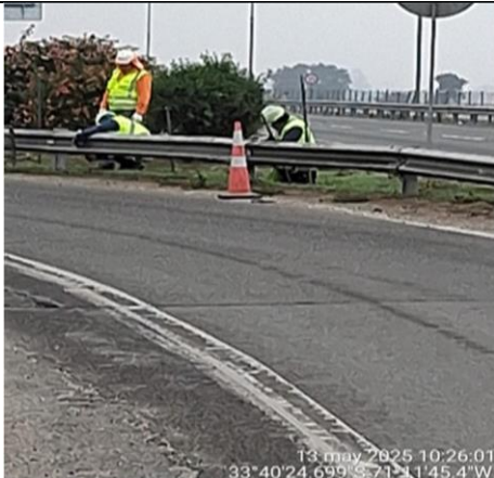
Mantenión de defensas -km. 65+550 Ascendente
