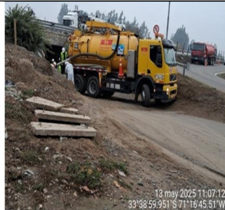
Mantenión Obra de Arte km.74+300 ascendente
