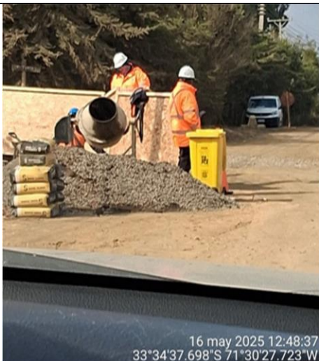
Trabajos de terceros-Chilquinta km. 98+400- CSD
