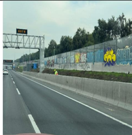
Limpieza y mantención de faja -km. 11+900
