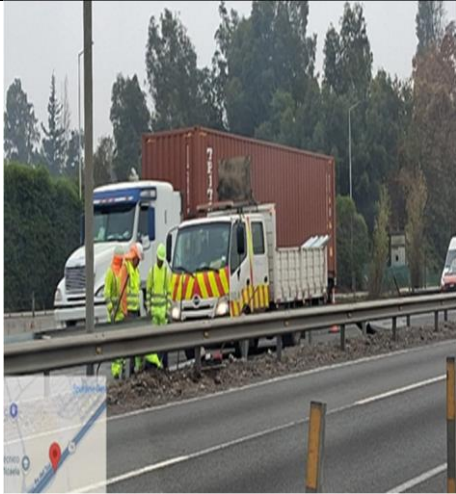
Reparación de Barrera en Mediana -km. 38+390
