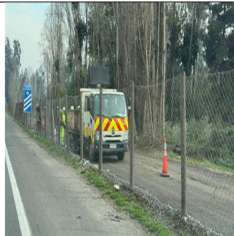
Limpieza y mantención de faja -km. 44+700
