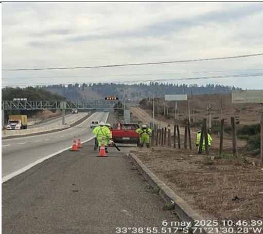
Limpieza de Bajadas de agua km.81+800- ascendente
