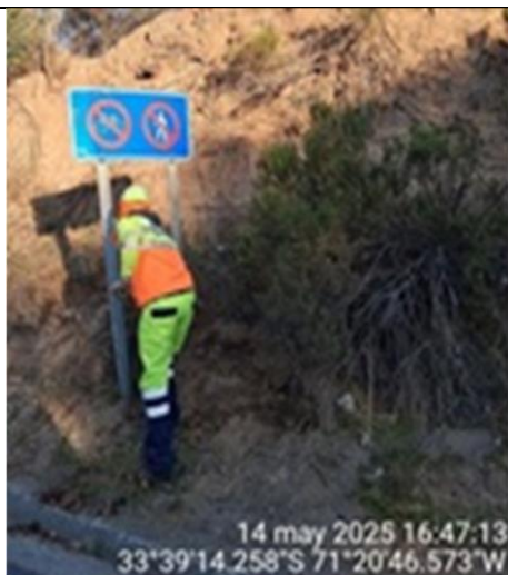
Mantenimiento señal vertical Km. 80+500- Ramal Puangue
