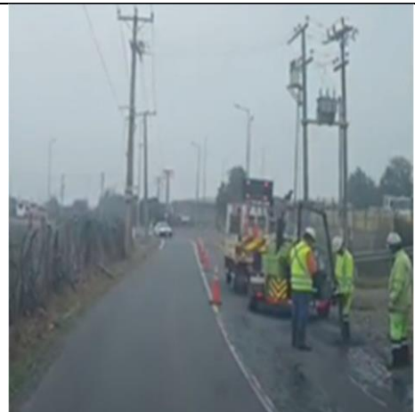
Sello de grietas CSI km. 39+900 a km. 43+000
