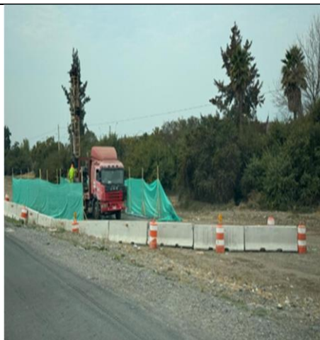
Sondaje en faja -km. 63+600
