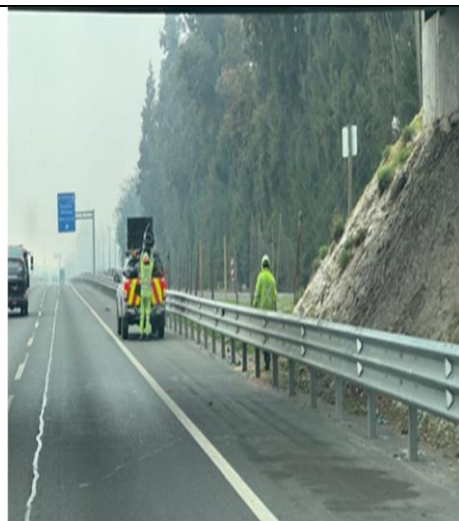
Limpieza y mantención de faja km. 30+100
