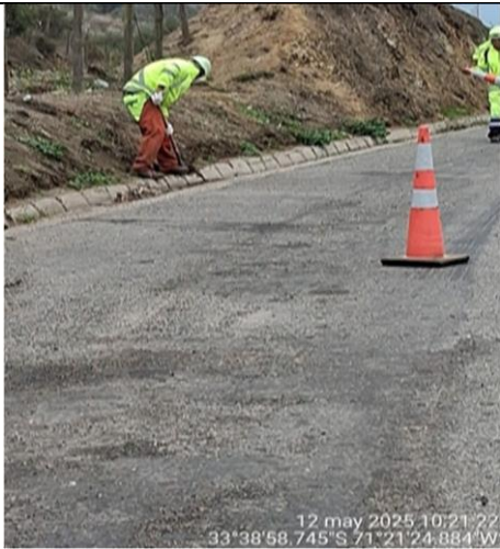
Limpieza de cunetas Km.81+600
