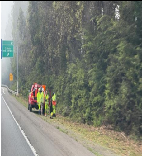
Limpieza y mantención de faja Km. 43+800
