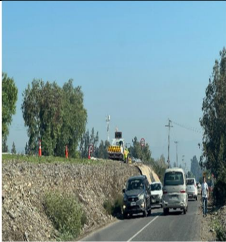
Limpieza y mantención de faja Km. 41+450
