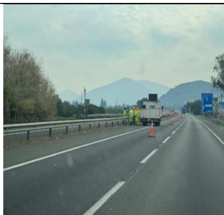
Limpieza y mantenimiento de faja km.8+600- Mediana
