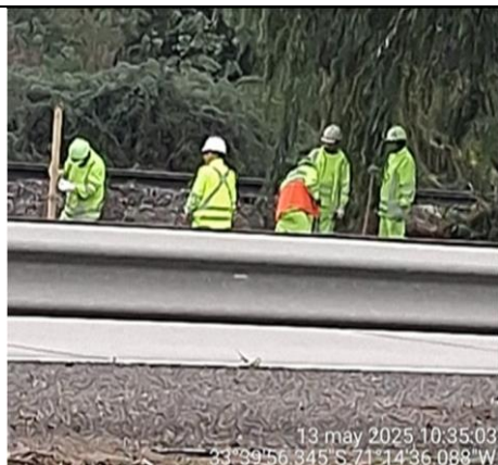
Reposición de cercos km. 70+300 descendente
