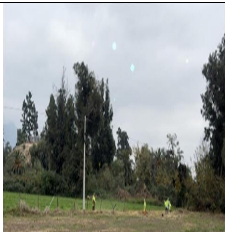
Limpieza de faja -km. 54+100 Descendente
