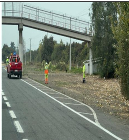
Limpieza y mantenimiento de faja km. 56+500 descendente
