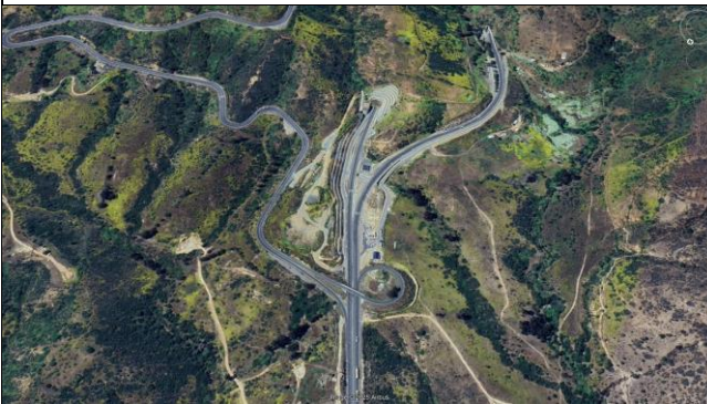
Enlace Acceso Norte Túnel El Melón
