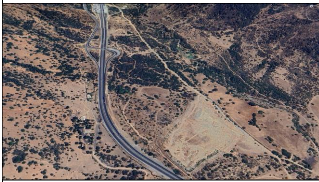
Enlace Acceso Sur Túnel El Melón
