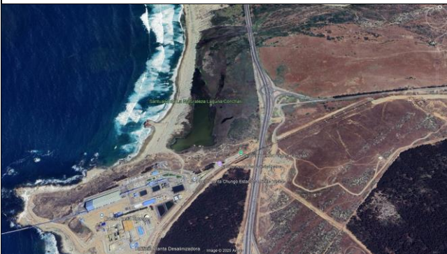
Término Concesión Ruta 5 Tramo Santiago – Los Vilos
