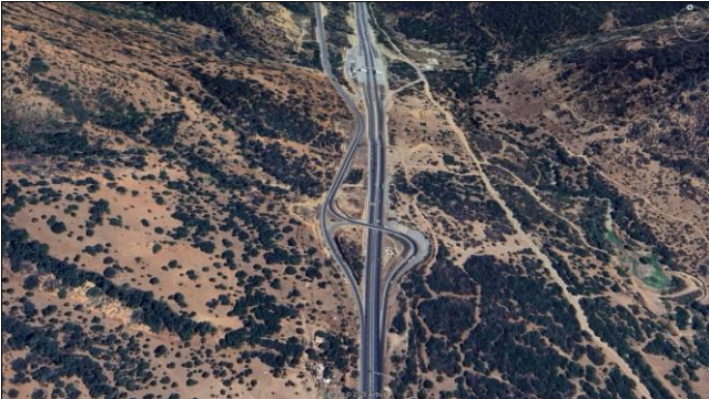
Enlace Acceso Sur Túnel El Melón
