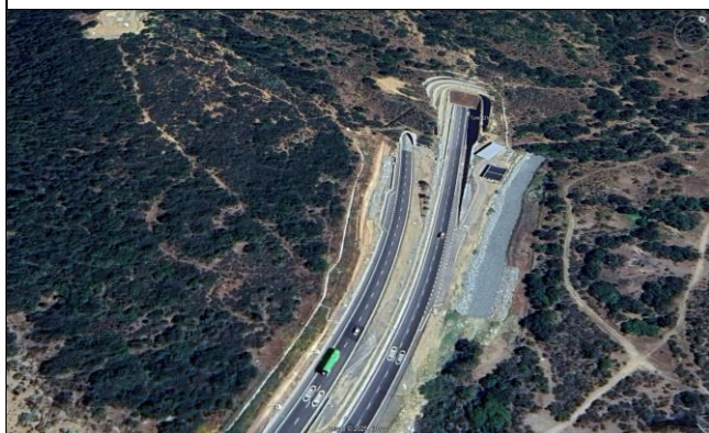
Acceso Sur Túnel El Melón
