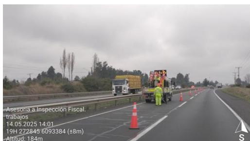
Dm 231,380 – Panorámica Poniente Sello de Grietas Pista 1
