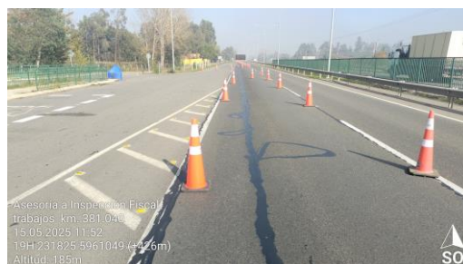
Dm 381,040 – Panorámica Oriente Sello de Grietas Pista 4
