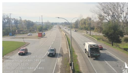
Dm 249,191 – Panorámica Vista Norte Paso Inferior Lircay.
