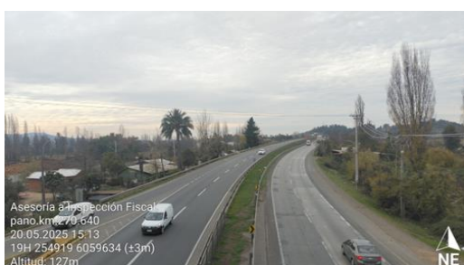
Dm 270,640 – Panorámica Vista Sur Pasarela La Palma.
