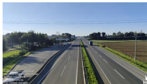
Dm 374,899 – Panorámica Vista Norte P.I. Cape.
