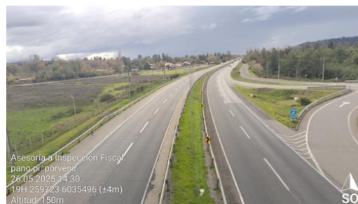
Dm 295,475 – Panorámica Vista Norte Paso Inferior Porvenir.
