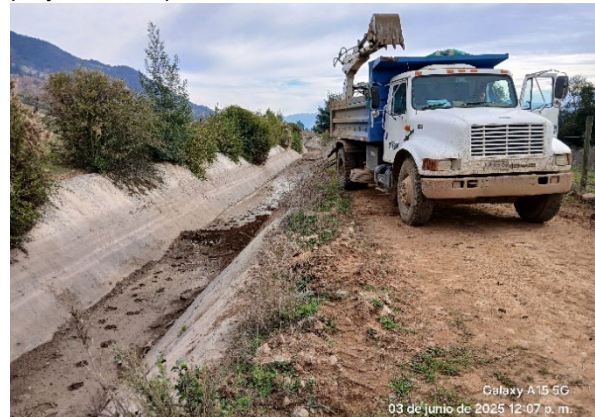
Imagen N°7. Canal Sur, Km 0+680Retroexcavadora y camión, actividad de limpieza de canal.
