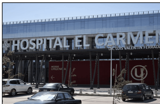
Concesión Hospital de La Florida
