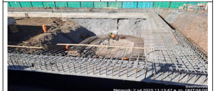
Sector Sala Eléctrica Tobalaba: Se observa abajo, la colocación de la armadura del Brocal proyectado para el Pique.
