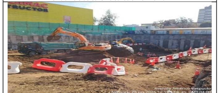
Sector Edificio de Control: Excavación masiva y retiro de escombros inmediato hacia botaderos autorizados.
