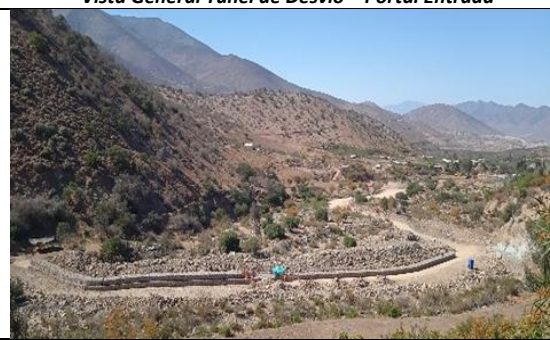
Estación Fluviométrica Las Carditas – Construcción Muro de Contención
