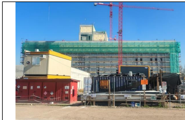
4.- Fachada Norte-Acceso principal
