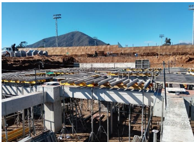
Moldajes de Losas (Sector E)
