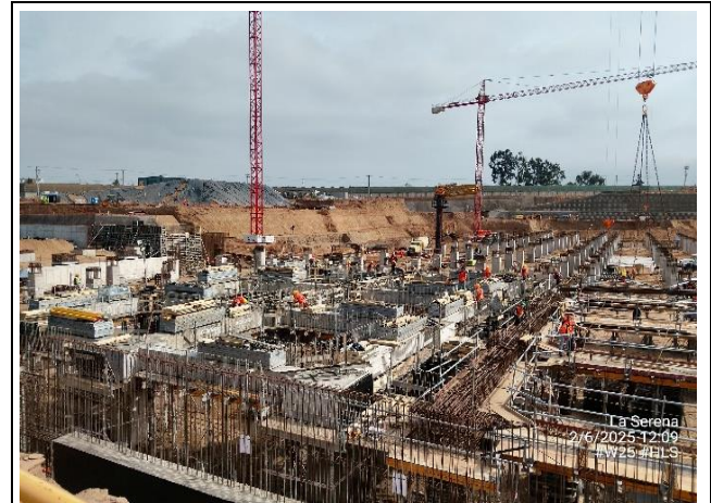
Vista Panorámica: Armaduras de Vigas y Capiteles (Sector F)
