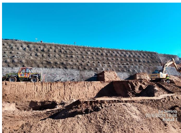
Refuerzo de Taludes (Sistema Soil Nailing)
