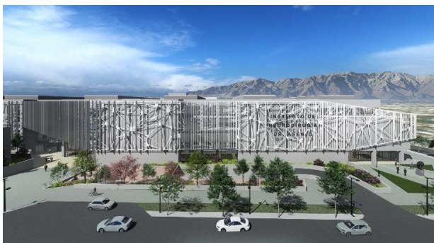
Vista poniente - Av. Salvador
