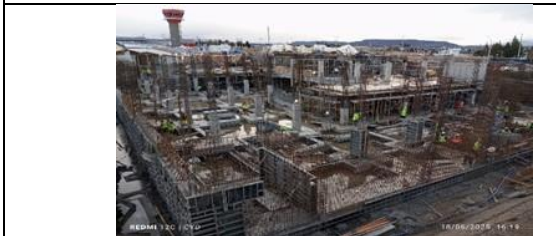
Edificio Estacionamiento Cubierto
