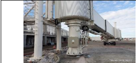
Instalación Pasarelas de Abordaje Móviles, proceso de montaje y ajustes de piezas como también instalación de tableros eléctricos.
