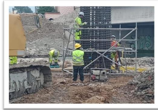
Foto 2: Ruta 5, Armadura de pilotes puente Huentelauquen.
