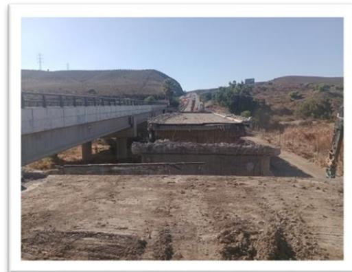
Foto 3: Ruta 5, Demolición de puente Quebrada Seca, vista desde estribo de entrada.
