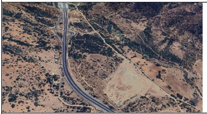
Enlace Acceso Sur Túnel El Melón
