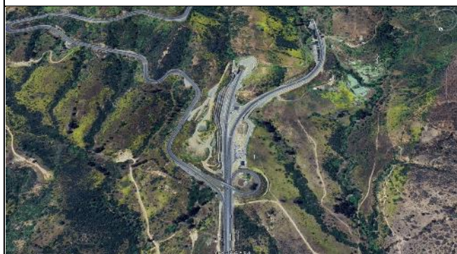
Enlace Acceso Norte Túnel El Melón
