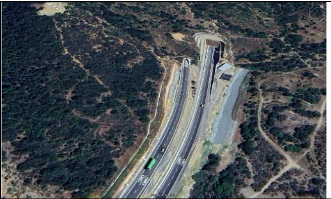
Acceso Sur Túnel El Melón
