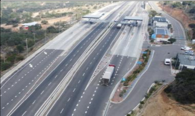
Plaza de Peaje Túnel Melón
