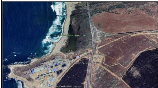
Término Concesión Ruta 5 Tramo Santiago – Los Vilos
