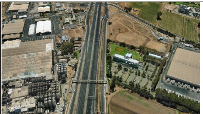
Inicio Concesión Ruta 5 Tramo Santiago – Los Vilos
