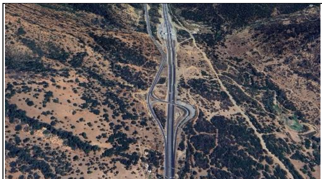
Enlace Acceso Sur Túnel El Melón
