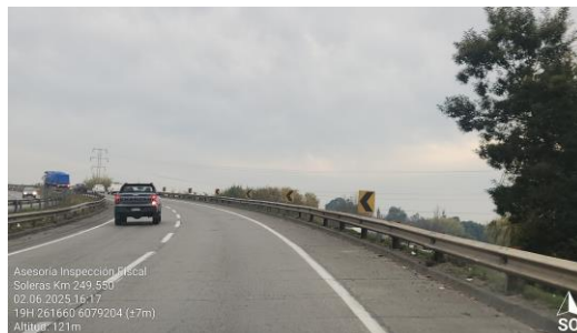
Dm 249,550 – Panorámica Soleras.
