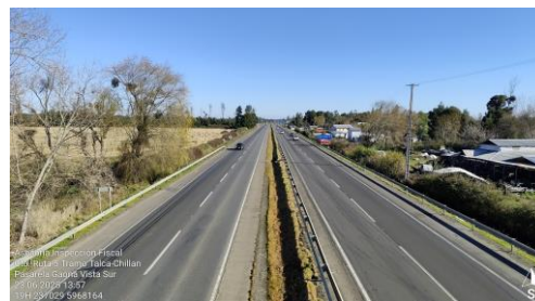
Dm 372,210 – Panorámica Vista Sur Pasarela Gaona.
