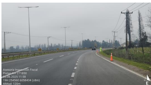
Dm 271,850 – Panorámica Pista 4 sector Poniente.
