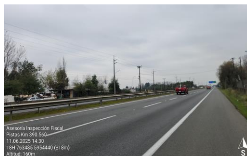
Dm 390,560 – Panorámica Pista 4 sector Poniente.
