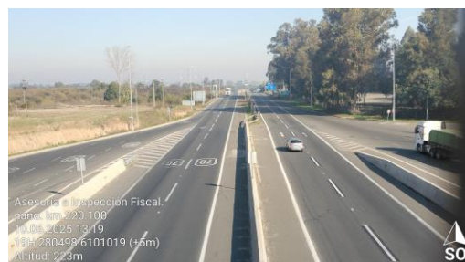
Dm 220,100 – Panorámica Pista 3, sector Oriente.
