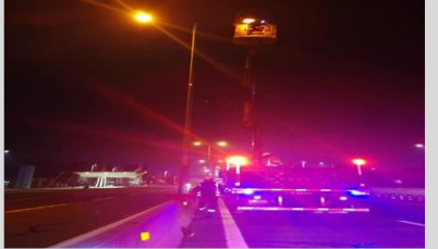
Observación y Reparación de luminarias.
