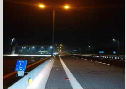
Inspección nocturna al estado de Iluminación en Vías Expresas
