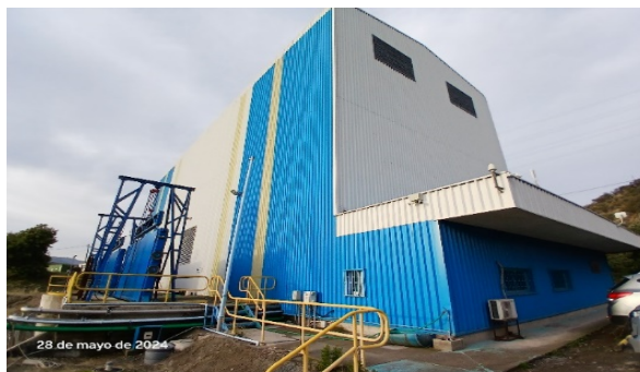
carta DE 01459-19) desde el 21 de febrero de 2019. Imagen N°4. Vista general de la Central Hidroeléctrica.
