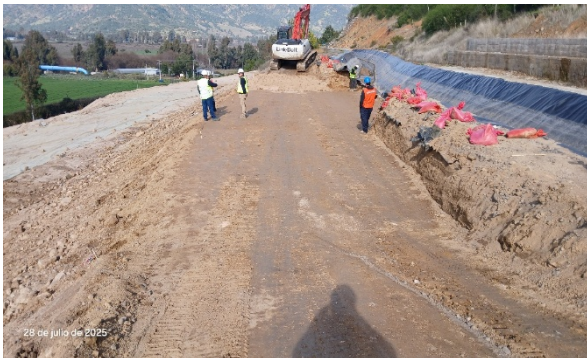
Imagen N°7. Canal Norte Unificado, Km 12+000
