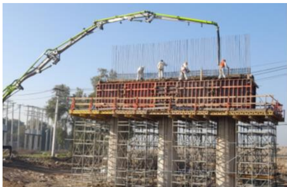
Dintel cepa P.I Enlace Acceso Norte Aeropuerto B4
