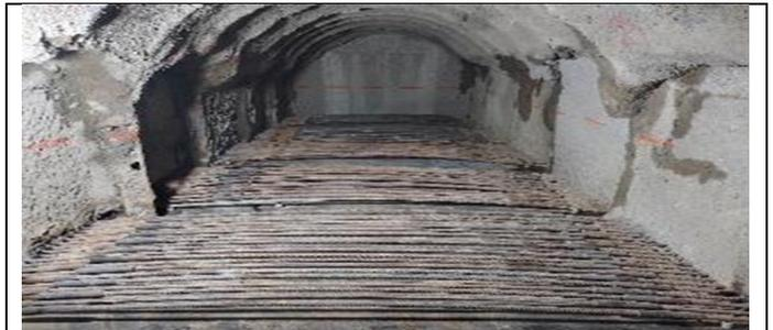
Costillas desde Galería Clave Túnel Alemán: Galería Clave, avance instalación de barras longitudinales de conexión entre costillas oriente y poniente
