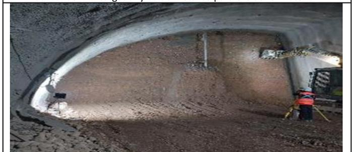
Túnel Vía Expresa Poniente, sección 4 carriles gravas En fase 1, avance tramos 08 al 03, Caverna Salida Simón Bolívar. Perfilada excavación.
