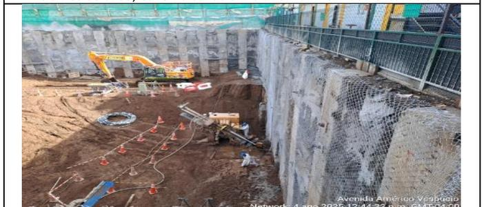
Sector Edificio de Control: Excavación masiva y trabajos de perforación en lado Poniente del sitio.
