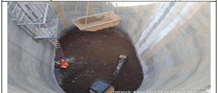
Pique Sector Guillermo Tell: Continúan los trabajos de excavación del Pique utilizando minicargador y balde metálico para extraer el material.
