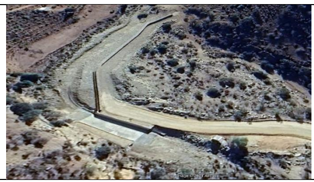
Fotografía N°5, Vista estación de control fluviométrica Frutillar
