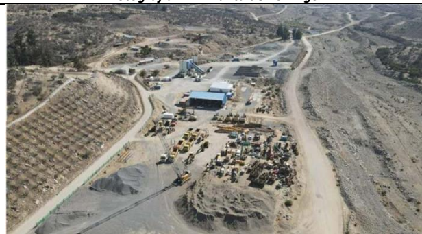
Fotografía N° 8. Lote 7, taller de maquinaria
