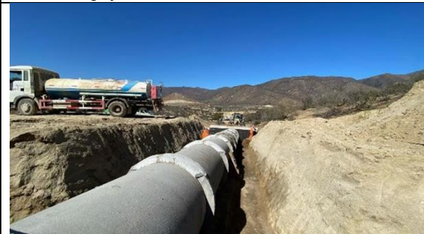
Fotografía N°2, Rellenos estructurales OA N° 21. Variante Ruta E315
