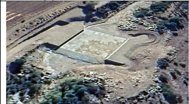
Fotografía N°4, Vista estación de control fluviométrica Las Carditas
