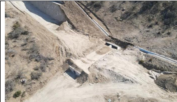
Fotografía N°1, Vista OA N°15. Variante Ruta E-315
