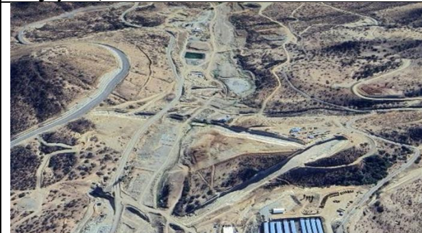
Fotografía N°3, Vista de las obras y campamento
