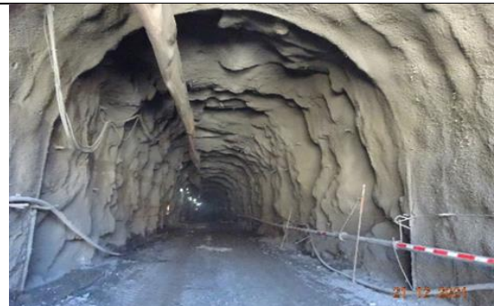
Vista General Túnel de Desvío – Portal Entrada
