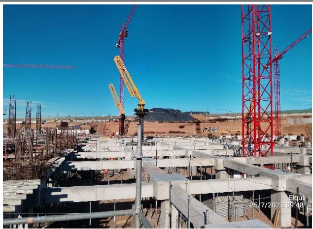
Vigas Nivel Aislación - Sector E
