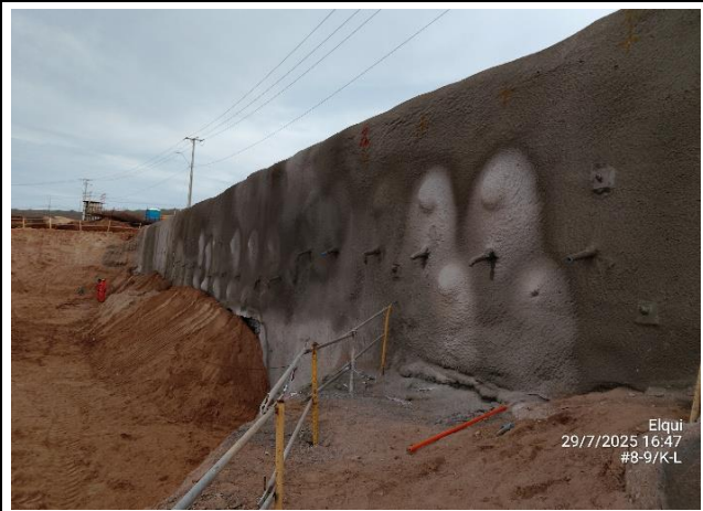
Refuerzo de Taludes (Sistema Soil Nailing)
