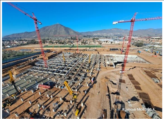
Vista Panorámica: Armaduras de Vigas y Capiteles (Sector F)
