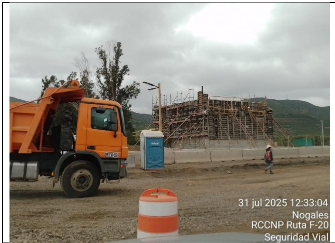
Sector 1 Km 5.7 al 4.9 Trabajos en estructura.
