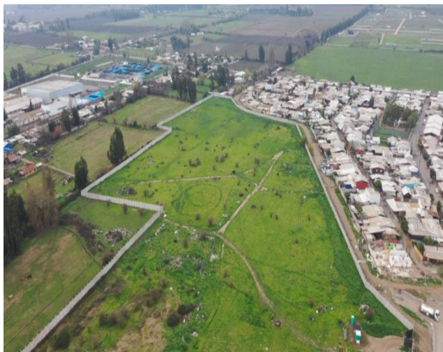
Estado actual del lote Hospital de Rengo
