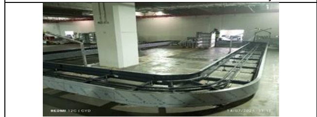
Instalación de Cintas Portamaletas BHS
