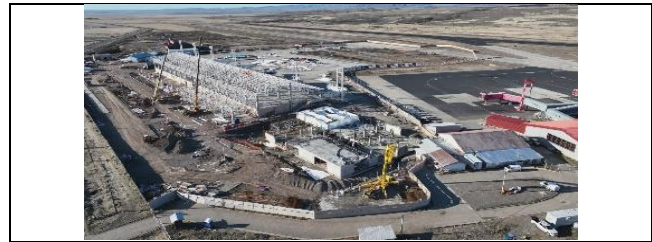
Vista general Aeródromo Balmaceda
