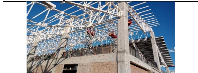
Instalación de Techumbre Edificio Terminal de Pasajeros.
