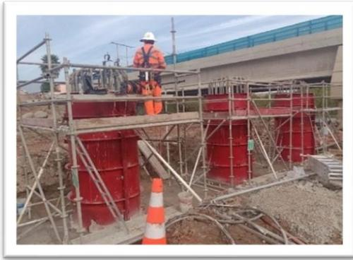
Foto 1: Ruta 5, Puente Huentelauquen Oriente, Pilas hormigonadas con moldajes instalados.
