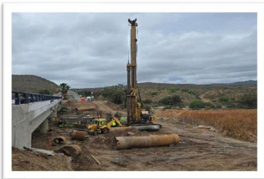
Foto 3: Ruta 5, Puente Quebrada Seca, Ejecución de Pilotes.
