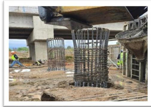
Foto 4: Ruta 5, Puente Quebrada Seca, Preparación Armadura de pilar para Cepa.
