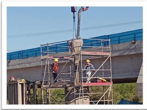
Foto 2: Ruta 5, Puente Huentelauquen Oriente, ejecución de hormigonado de Pilotes.
