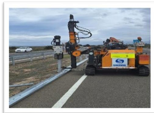
Foto 6: Ruta 5, Incado barreras metálicas sector interurbano, Proyecto Seguridad Vial.
