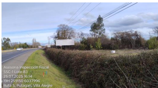
Dm 292,900 – Panorámica Lote 83 Proceso Toma Posesión de Terreno.
