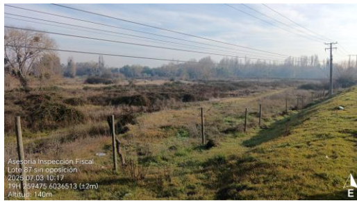
Dm 294,420 – Panorámica Lote 87 Proceso Toma Posesión de Terreno.
