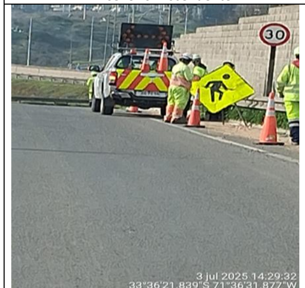
Roce Mecanizado Km. 72+300- Ascendente
