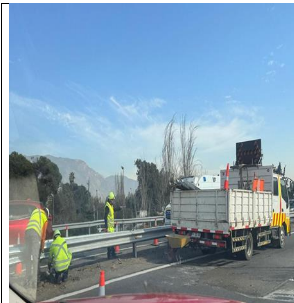
Reparación de Barrera doble onda km.53+300- Mediana
