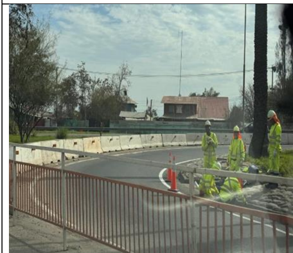
Mantenimiento de OA Km. 28+600- Ascendente
