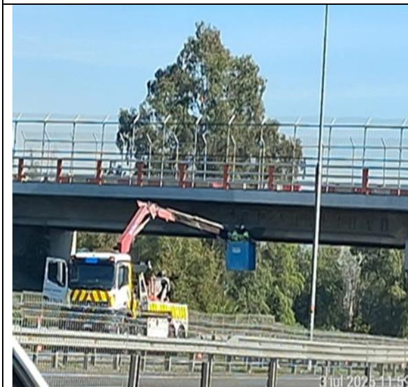
Reparación de Viga. Enlace Melipilla. km.65+650- Ascendente
