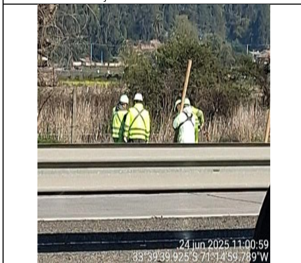
Reposición de Cercos km. 71+100- Descendente
