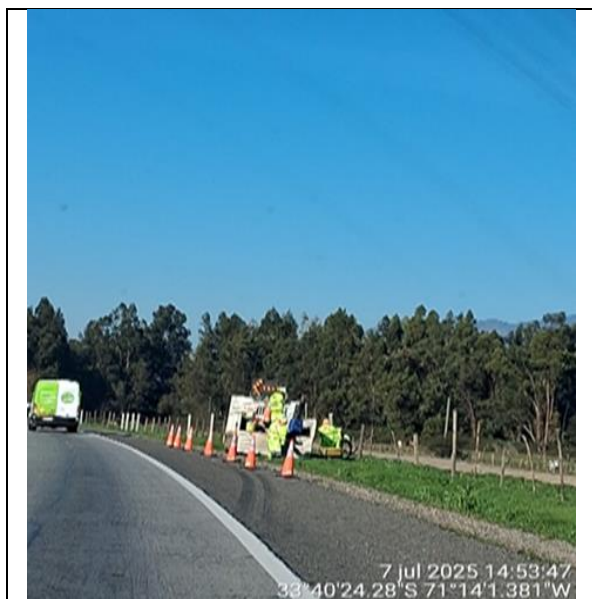
Reposición de cercos km.68+850- Descendente
