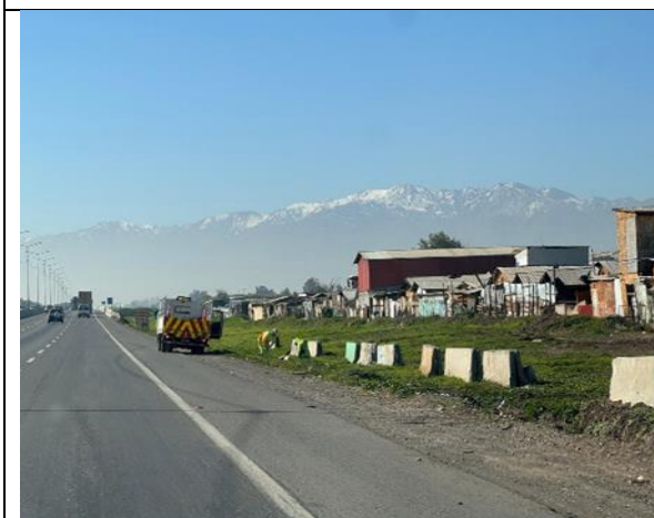
Limpieza y Mantenimiento de Faja km.13+350- Descendente
