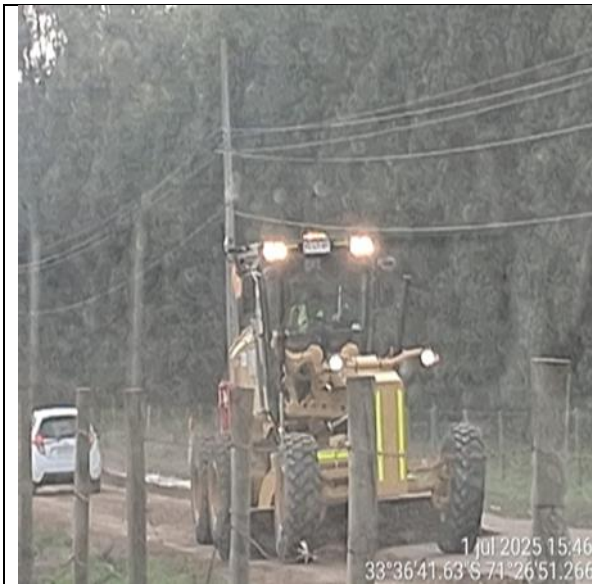
Mantenimiento de Calle de Servicio Km. 91+300- Ascendente
