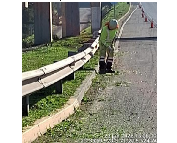
Mantenimiento de Soleras. Km. 95+010- Descendente
