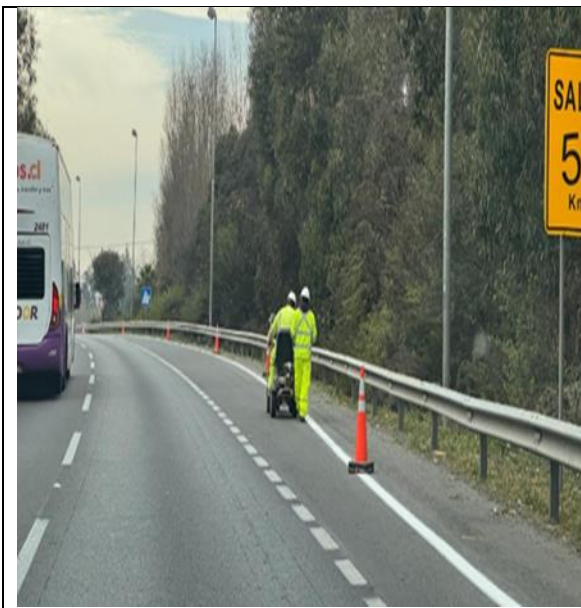
Demarcación -km. 43+700 Descendente
