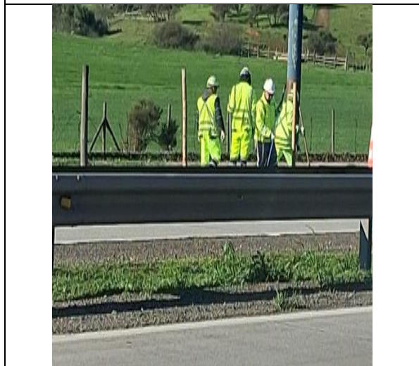
Reposición de Cercos Km. 85+880- Ascendente
