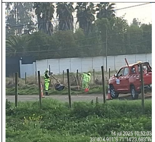
Mantenimiento de Foso km.70+0- Ascendente CS
