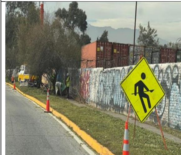
Limpieza de faja Km. 1+800- Descendente
