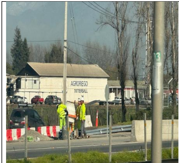
Trabajos en nuevo acceso Talagante km. 38+450 Descendente
