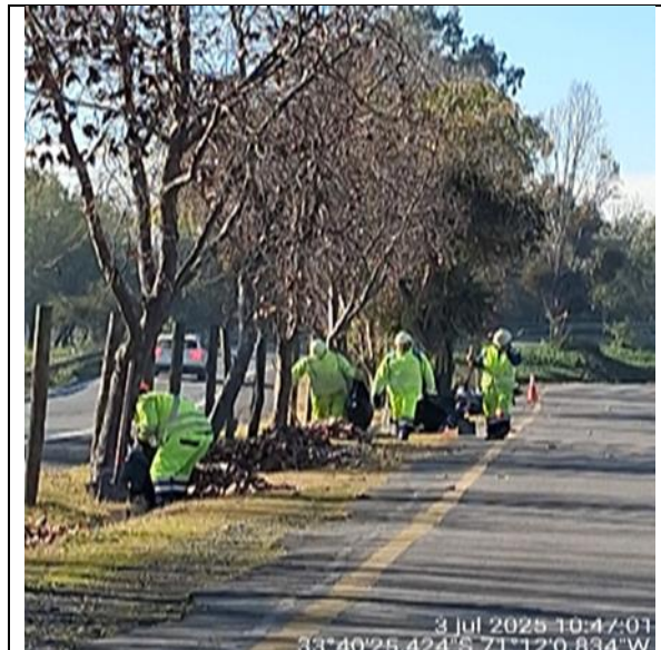
Limpieza de faja Km. 65+970- Ascendente
