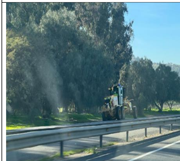
Roce Mecanizado Km. 53+300- Ascendente
