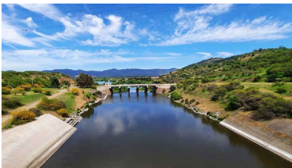
Imagen N°2. Vista general agua abajando desde la Presa Auxiliar.
