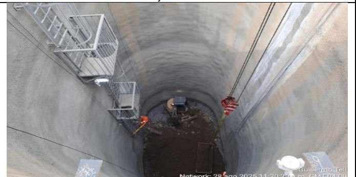
Pique Sector Guillermo Tell: Excavación con minicargador, con un avance de 21,45m, un 54%.
