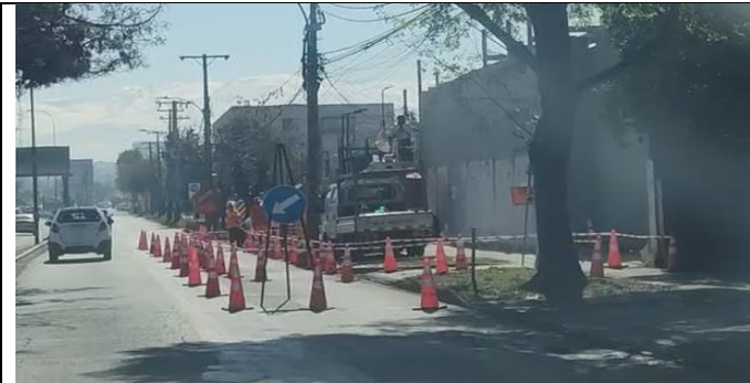
Instalación de faena por demoliciones
