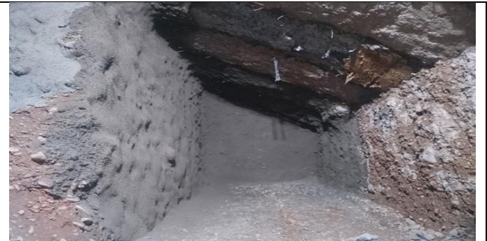
Túnel Vía Expresa Oriente: Inicio excavación tramo superior túnel alemán, bajo costillas.
