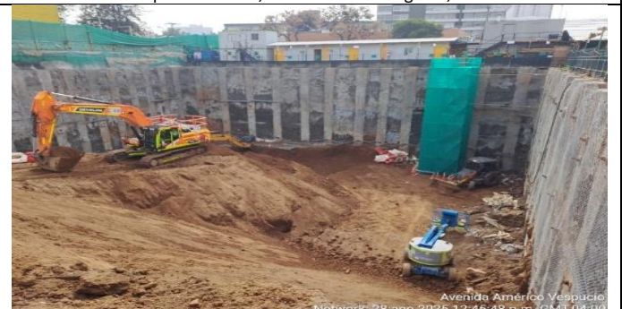
Sector Edificio de Control: Excavación masiva: Vista Sur - Norte del sitio donde se observa parte del socializado ejecutado.
