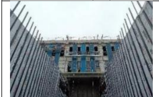
Fachada ventilada Edificio Principal en patios interiores.
