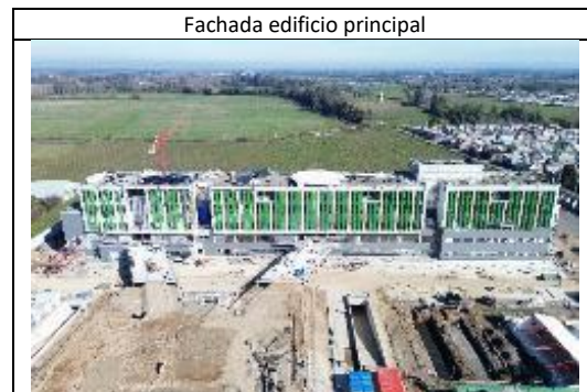
Fachada Sur, instalación de quiebra soles
