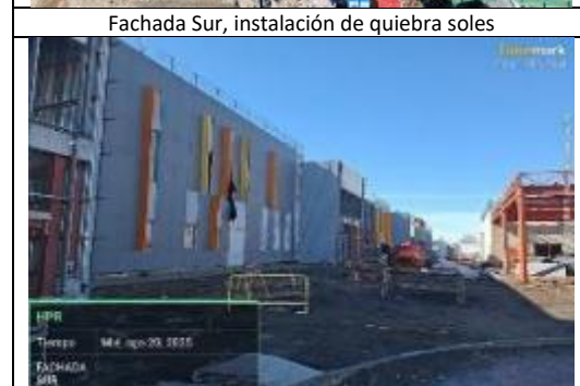
Fachada Sur, instalación de quiebra soles
