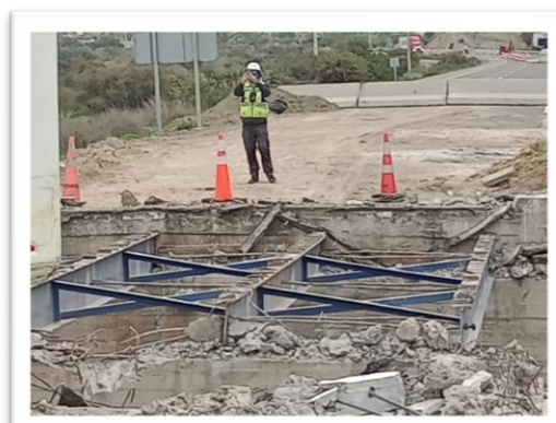
Foto 5: Ruta 5, Puente El almendro Oriente, Vigas despejadas (losa demolida).
