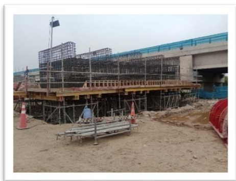
Foto 1: Ruta 5, Puente Huentelauquen Oriente, vista general de enfierradura de Dintel.
