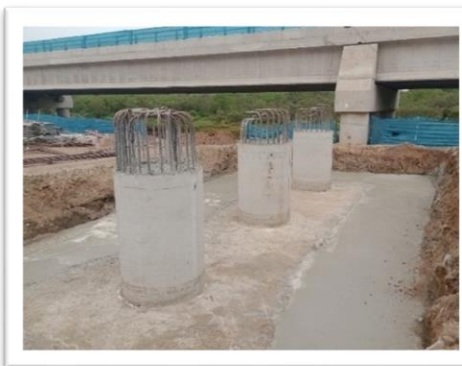
Foto 2: Ruta 5, Puente Huentelauquen Oriente, pilas hormigonadas de cepa 5.
