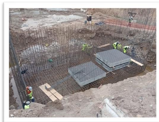
Foto 3: Ruta 5, Puente Quebrada Seca, Enfierradura y preparación de Moldajes de fundaciones de estribo de acceso.
