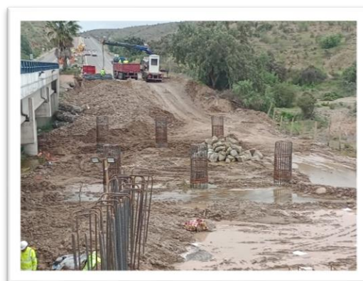
Foto 4: Ruta 5, Puente Quebrada Seca, vista general de área de trabajo. Pilas y pilotes.
