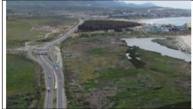
Término Concesión Ruta 5 Tramo Santiago – Los Vilos
