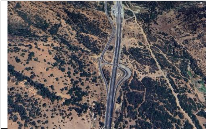
Inicio Concesión Túnel El Melón
