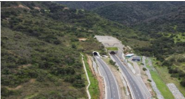
Acceso Sur Túnel El Melón
