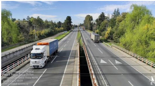
Dm 221,830 – Panorámica vista norte pasarela Camarico.
