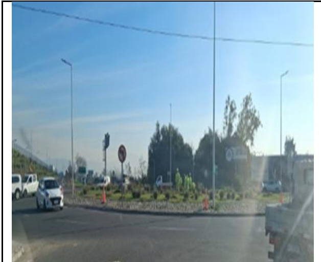
Limpieza y Mantención de Faja km.38+650- Ascendente
