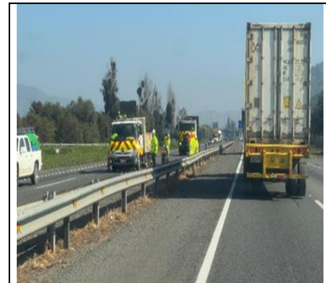
Limpieza y Mantención de Mediana Km. 61+900- Mediana
