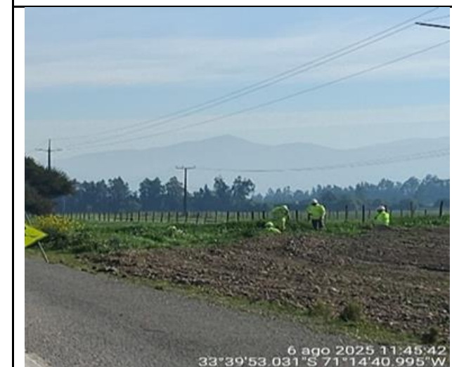
Mantención de obras de arte km.70+500- Ascendente
