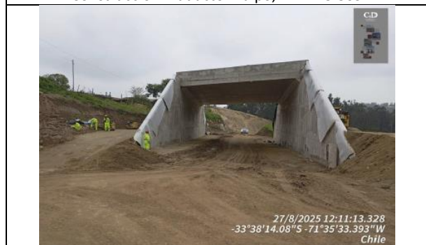
Construcción Paso Superior Enlace San Juan Dm 129.740
