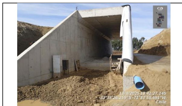
Construcción Paso Superior Interpredial N°132 Dm 132.255
