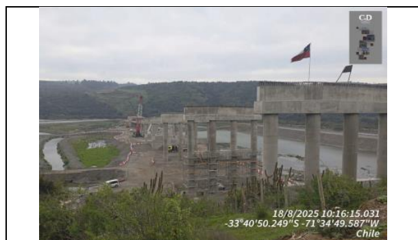
Construcción Viaducto Maipo, Dm 125.309
