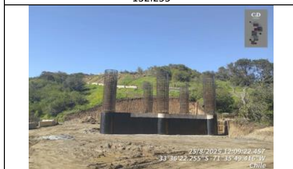
Construcción Viaducto Las Lajas, Dm 136.200 – Dm 136.656
