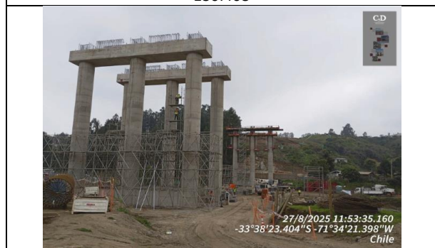
Construcción Viaducto San Juan Dm 130.599 - 130.959
