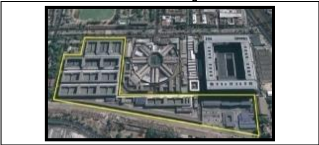
Establecimiento Penitenciario Valdivia
