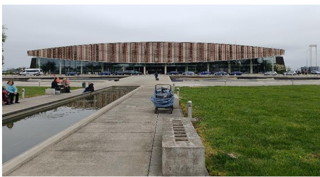
Vista Frontal del Aeropuerto de La Araucanía
