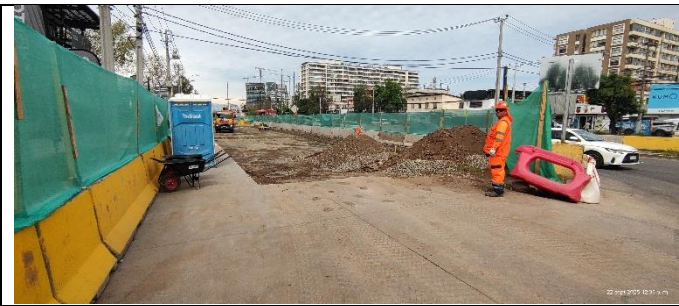
Obras previas TSSB fase 2
