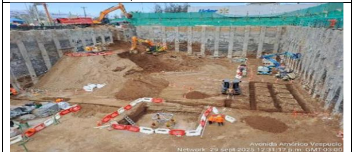
Sector Edificio de control, vista panorámica excavación.
