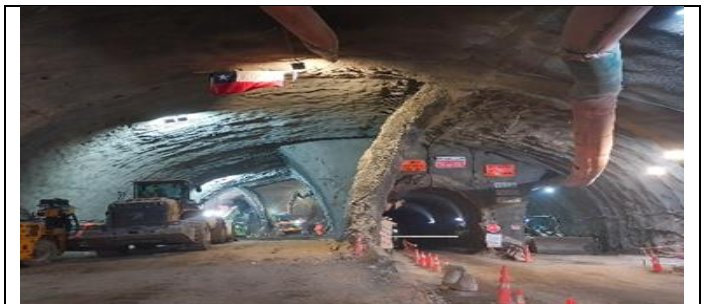
Túnel híbrido, vista panorámica.
