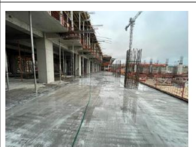
Losa cielo subterráneo eje 0
