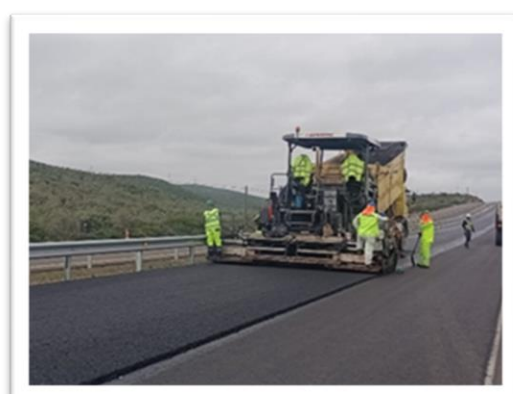
Foto 6: Ruta 5, Recapado de pavimento asfáltico, Finisher extendiendo la mezcla asfáltica.
