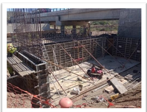
Foto 3: Ruta 5, Puente Quebrada Seca, Estribo de salida preparación de moldajes.
