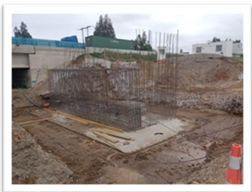
Foto 2: Ruta 5, Puente Huentelauquen Oriente, estribo de salida en proceso de hormigonado.
