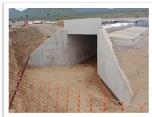
Foto 4: Ruta 5, Atraveso Playa Ñahue, Muros de ala poniente.
