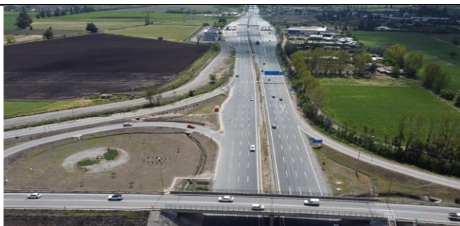
Enlace Bатуco Liray (km 25.5)
