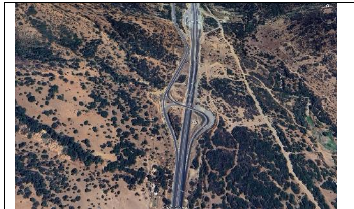
Inicio Concesión Túnel El Melón (km 124.54)
