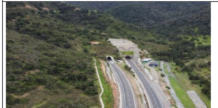
Acceso Sur Túnel El Melón (km 128.831)
