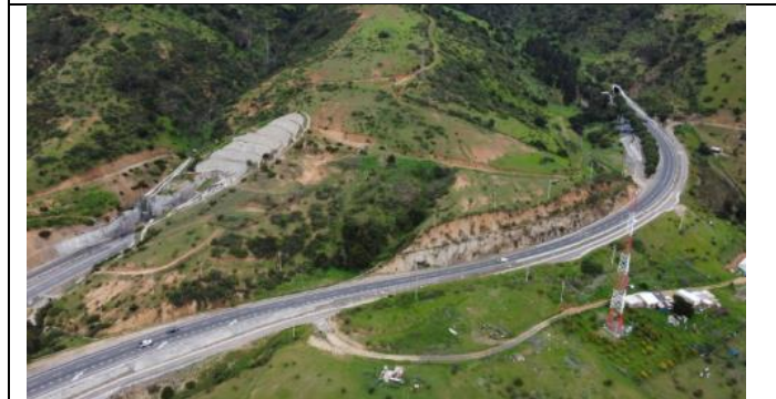
Acceso Norte Túnel El Melón (km 135)
