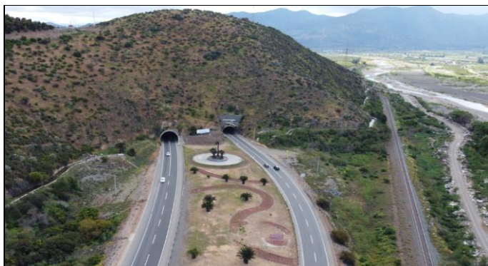
Acceso Sur Túnel La Calavera (km 93.6)
