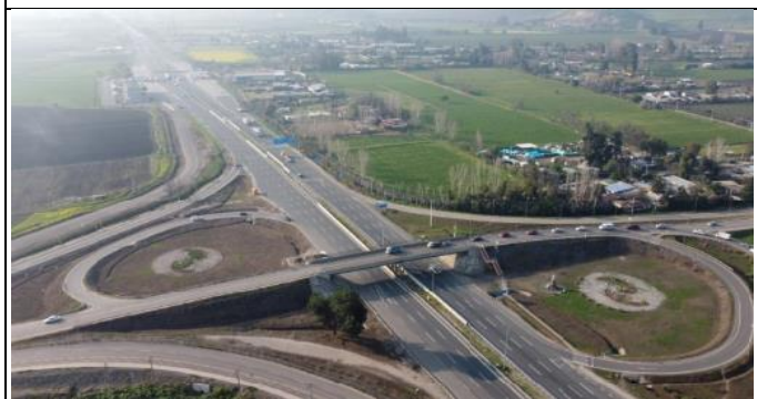
Enlace Bатуco Liray (km 25.5)
