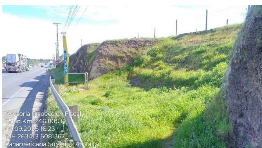
Dm 246.800 – Talud, lado poniente
