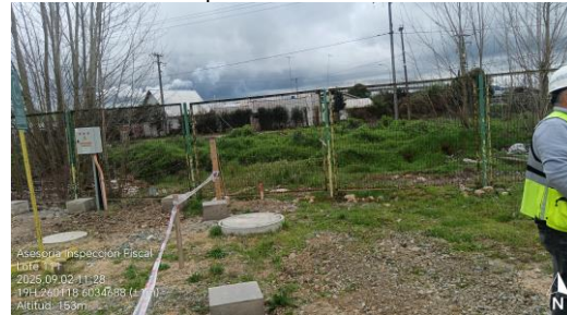
Dm 295.620 – Toma posesión material S1SSC Lote 111.
