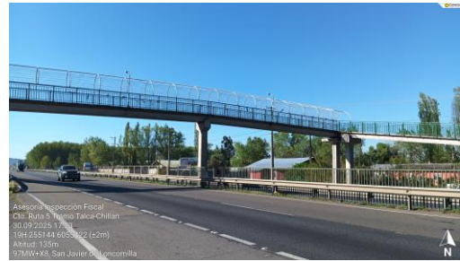
Dm 274.960 – Pasarela San Patricio, lado poniente, vista al norte.
