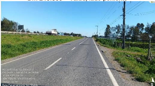
Dm 260.140 – Calle de servicio lado poniente, vista al sur
