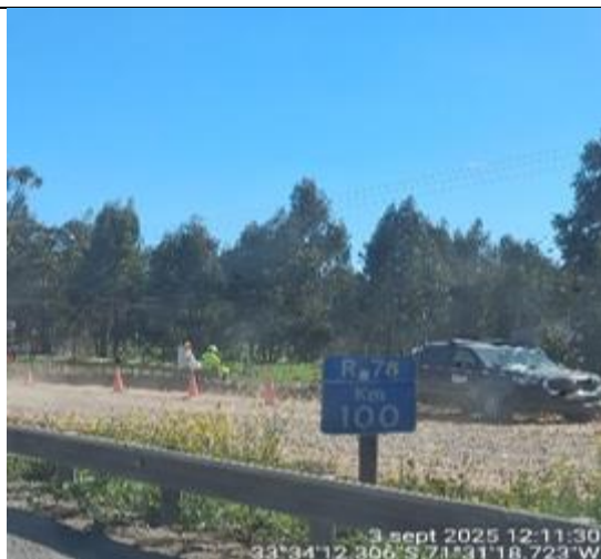
Mantenición de obras de arte km.100+000- Ascendente
