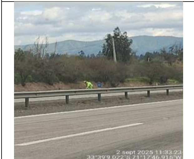
Limpeza de soleras Km. 75+860- Descendente
