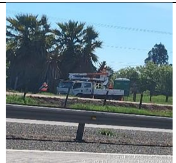
Poda Mecanizado Km. 76+020- Ascendente
