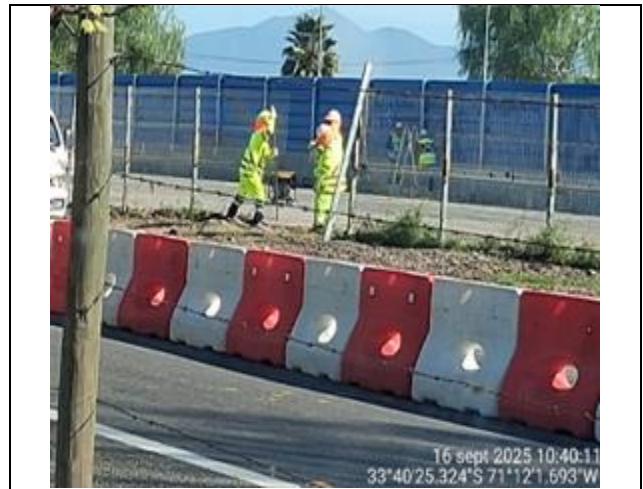
Cierre Perimetral Área de Emergencia. - km. 66+000 Descendente
