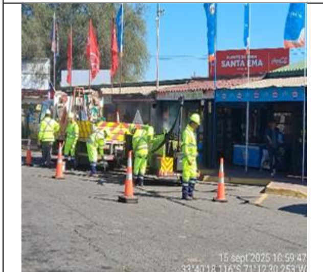
Sello de grietas- Las Palomitas km.66+750- Ascendente
