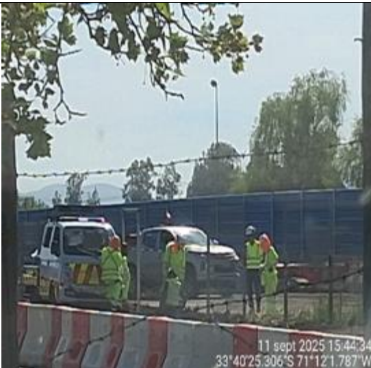
Cierre Perimetral Área de emergencia- km. 66+000 Descendente
