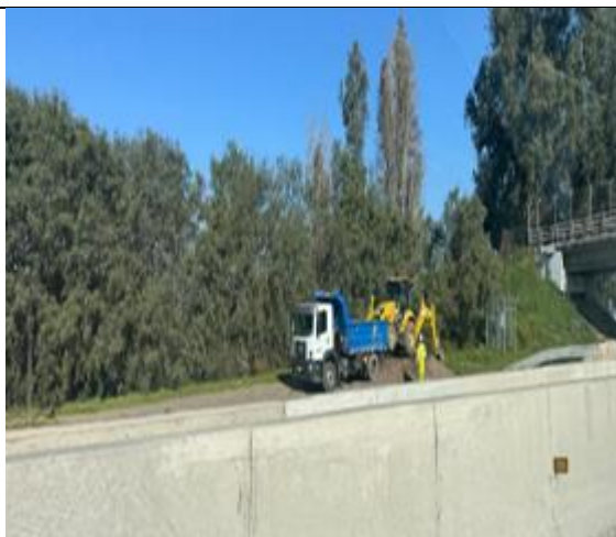
Retiro de escombros km.18+100- Descendente
