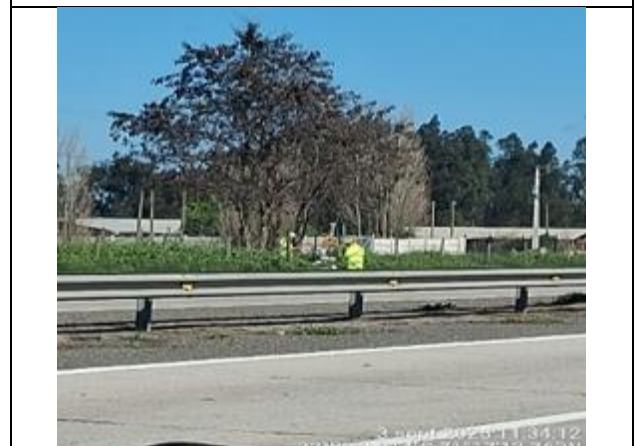
Reposición de Cercos-km. 75+100 Descendente
