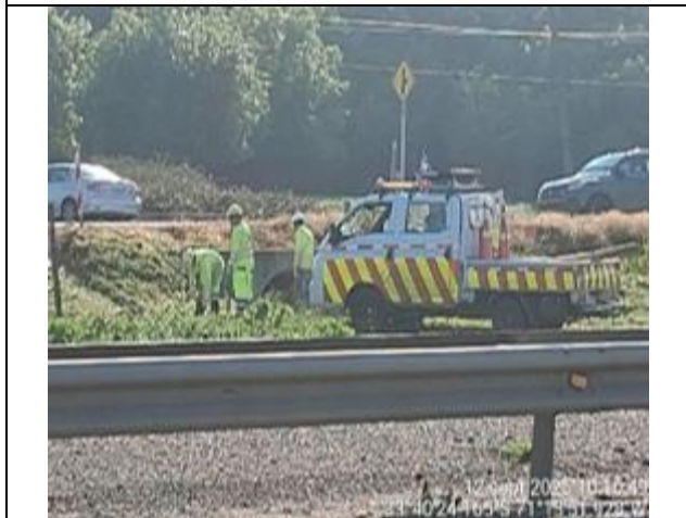
Reposición de Cercos- Km. 68+300- Calle de Servicio Derecha
