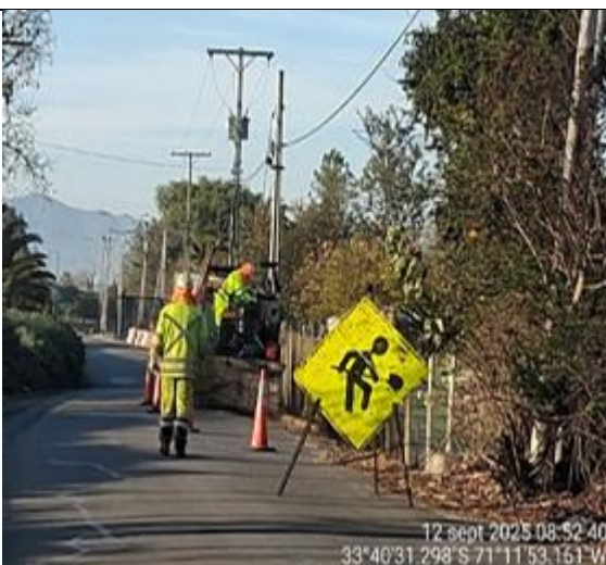
Mantenimiento de calzada-Km. 65+600- Descendnete
