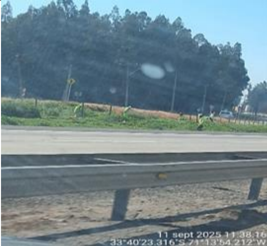
Roce y Limpieza de Faja Km. 68+940- Ascendente
