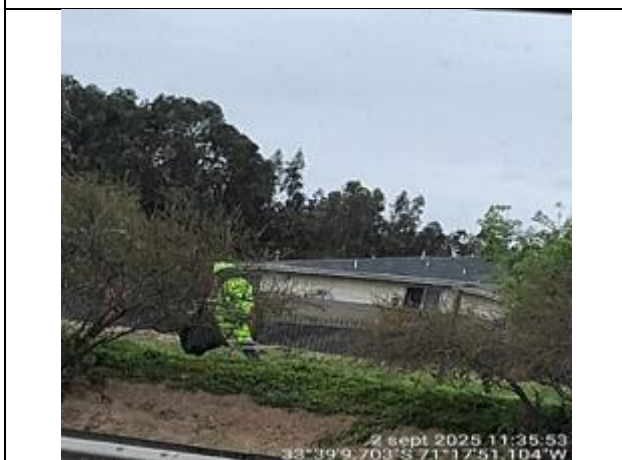
Limpeza y Mantenimiento de Faja km.75+980- Calle de Servicio Izquierda
