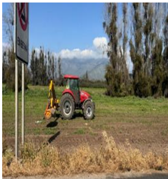
Roce de faja mecanizado Km. 53+900- Ascendente
