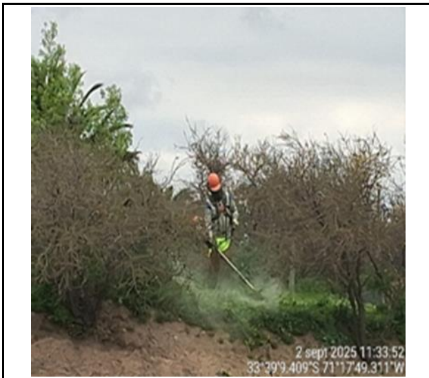
Limpeza y Mantenimiento de Faja km.75+930- Descendente
