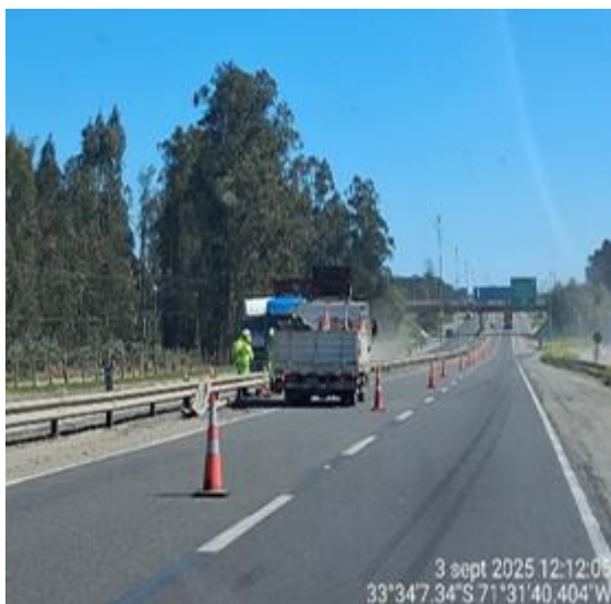
Reposición de Barreras Km. 100+600- Descendente
