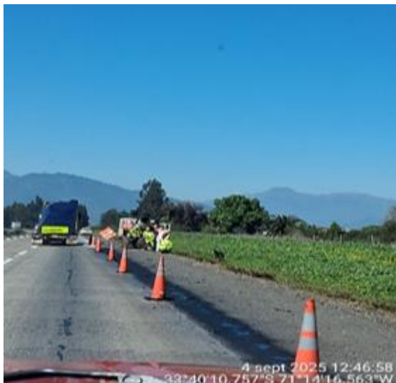
Mantención de Berma km.69+500- Descendente
