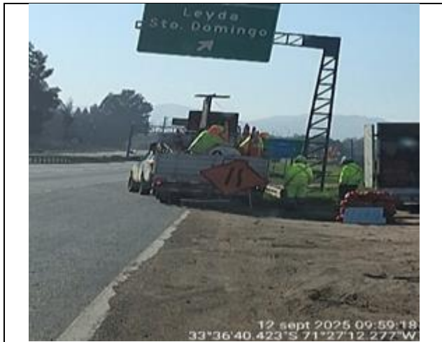
Mantenimiento de bermas- km.91+200- Descendente
