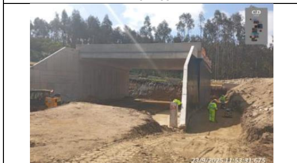
CONSTRUCCIÓN PASO SUPERIOR INTERPREDIAL REUSS (DM 133.733) N°133 (Ex 21)
