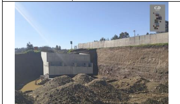
Construcción Paso Inferior Conexión Ruta G-908 Dm 130.408
