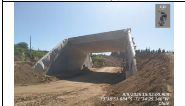
Construcción Paso Superior Enlace San Juan Dm 129.740
