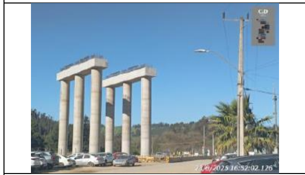
Construcción Viaducto San Juan Dm 130.599 - 130.959
