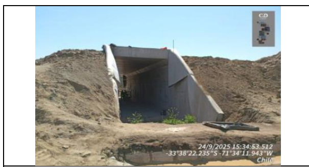
Construcción Paso Superior Interpredial N°132 Dm 132.255
