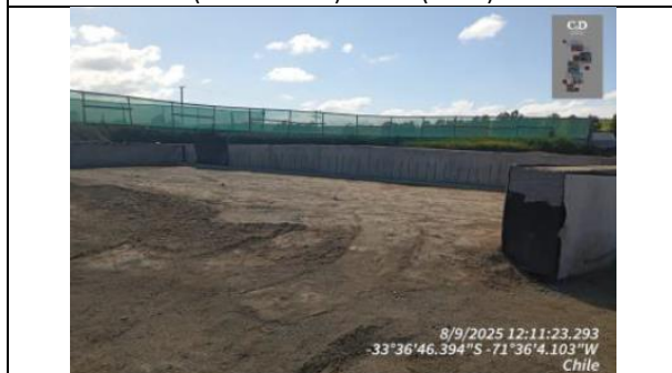
CONSTRUCCIÓN PASO SUPERIOR LOS ALERCES (DM 132.679)
