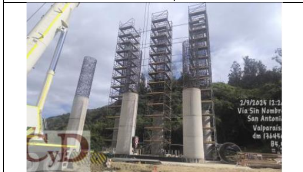
CONSTRUCCIÓN VIADUCTO LAS LAJAS (DM 136.200 - 136.652)
