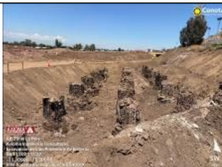
Foto N°4 Estructura Av. El Cerro 28.30.25
