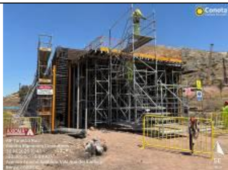
Foto N°3 Estructura N°3 (E3) 30.10.25
