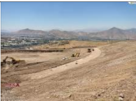
Foto N°7 Excavación Masiva Lado Norte (30.10.25)
