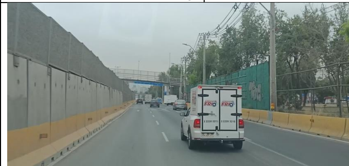
Desvío Trinchera Expresa Oriente
