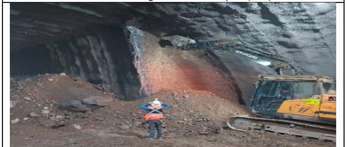
Caverna Salida Tobalaba Oriente (CSTO), se avanza por fase 2, a marco 627, último de tramo 6, en Dm 9.349,790
