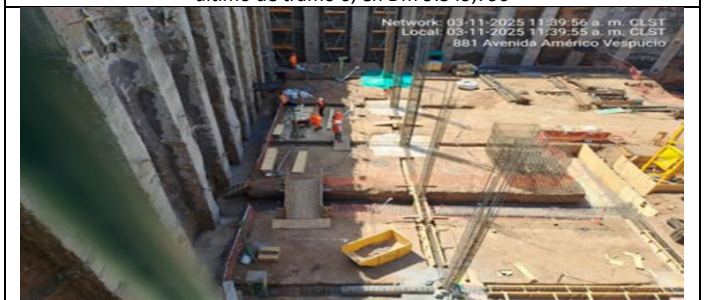
Sector Edificio de Control: Vista parcial de fundaciones hormigonadas en el eje 2.
