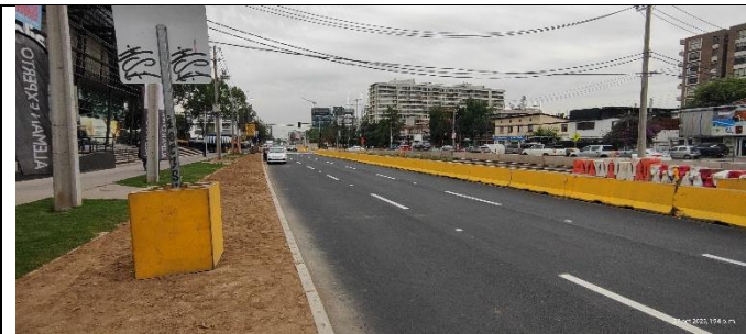
Desvío Trinchera Salida Simón Bolívar fase 2
