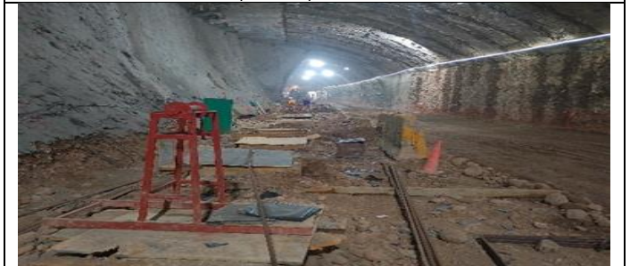
Túnel Alemán: Se avanza en confección de pilas en el eje central, se encuentran hormigonadas 25 de 29 pilas (86%).
