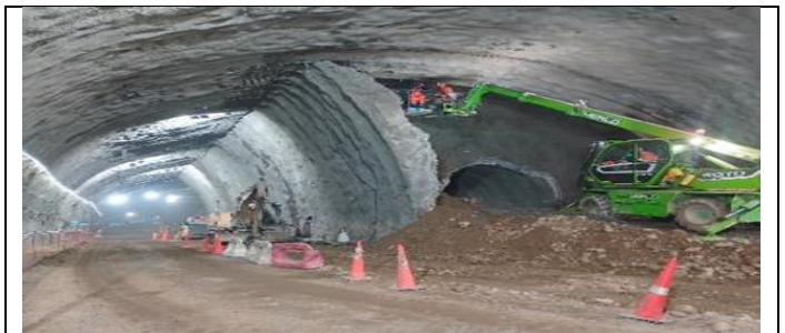
Túnel Híbrido sección D se inicia avance por fase 3, previa demolición de muro temporal en primeros 13 marcos.
